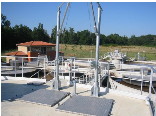
L'extension de la station d'épuration par Réseau 31
