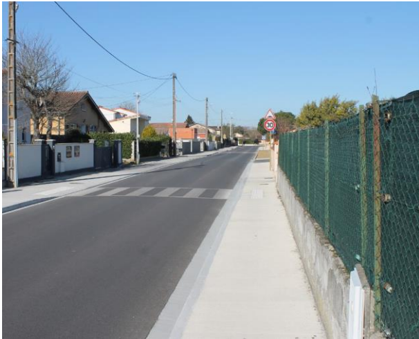
Réfection de la rue de la Bigorre
