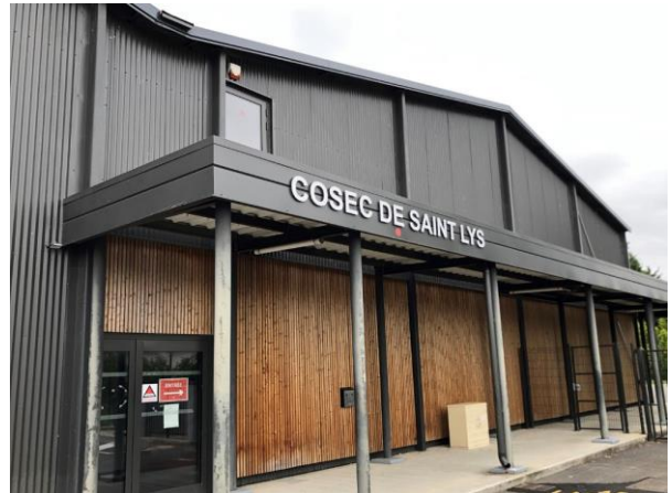
Le COSEC a été rénové, notamment sur le plan énergétique, il a également bénéficié d'un agrandissement.
