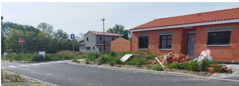
Figure 18 : Photographie de la maison en construction sur le secteur, mai 2023
