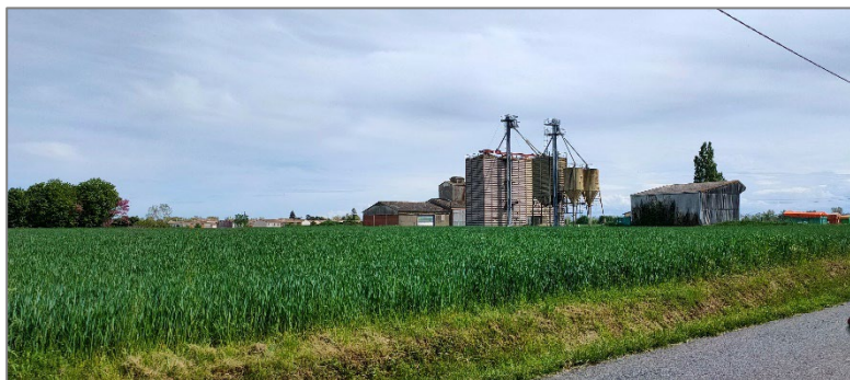
Photo : Silos de la Coopérative Arterris, 2023, BE PAYSAGES.
