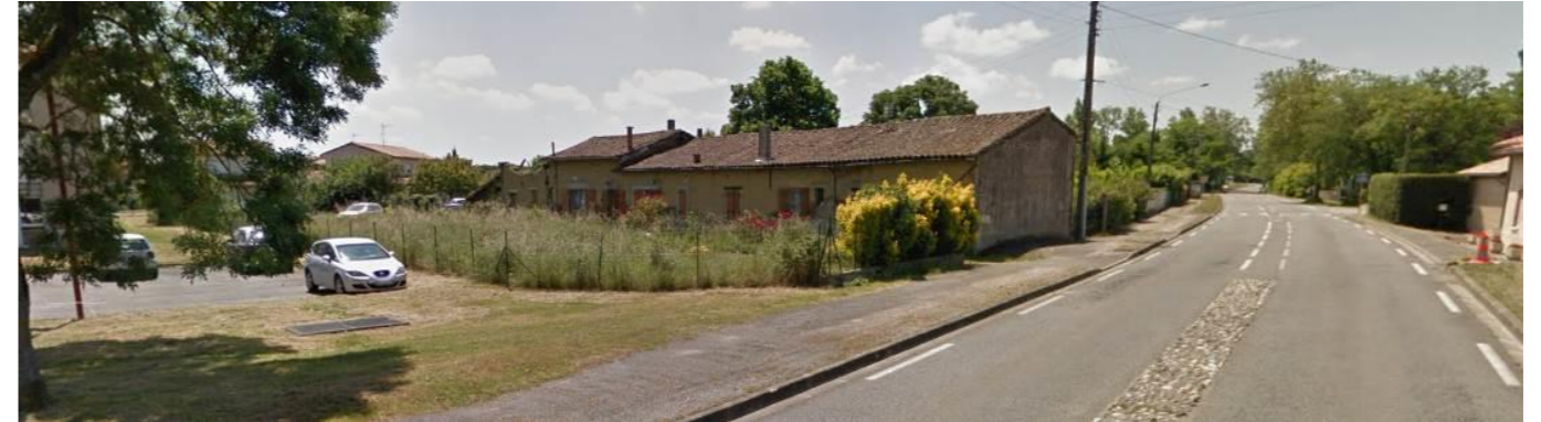
Photo 12 – Vue depuis l'avenue des Pyrénées
