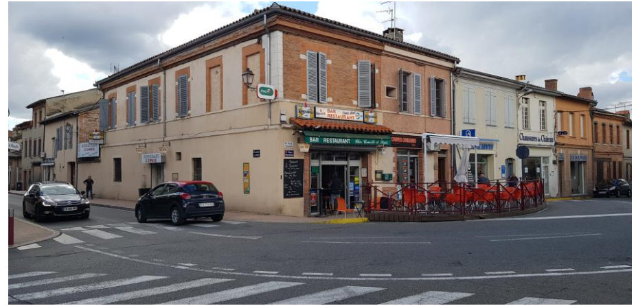
Vues 5 et 6. Accumulation d'enseignes en drapeau dans plusieurs endroits du centre-ville
