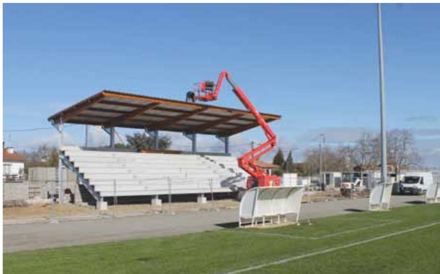
La structure métallique, une partie des gradins et la toiture de la future tribune sont en place
