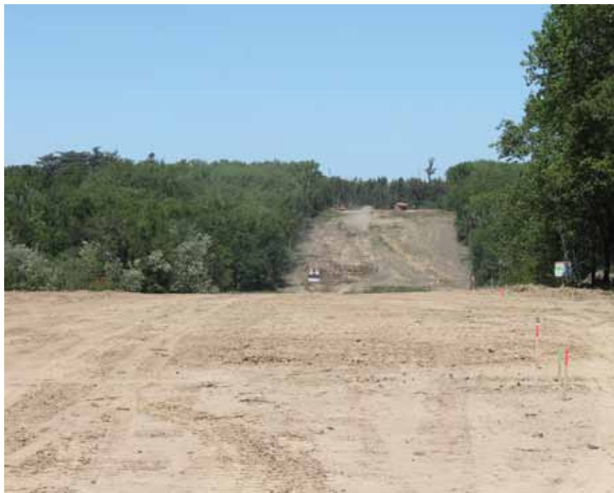
Le chantier a débuté par des travaux de terrassement et se poursuivra par la construction du pont qui enjambera l'Ayguebelle.
