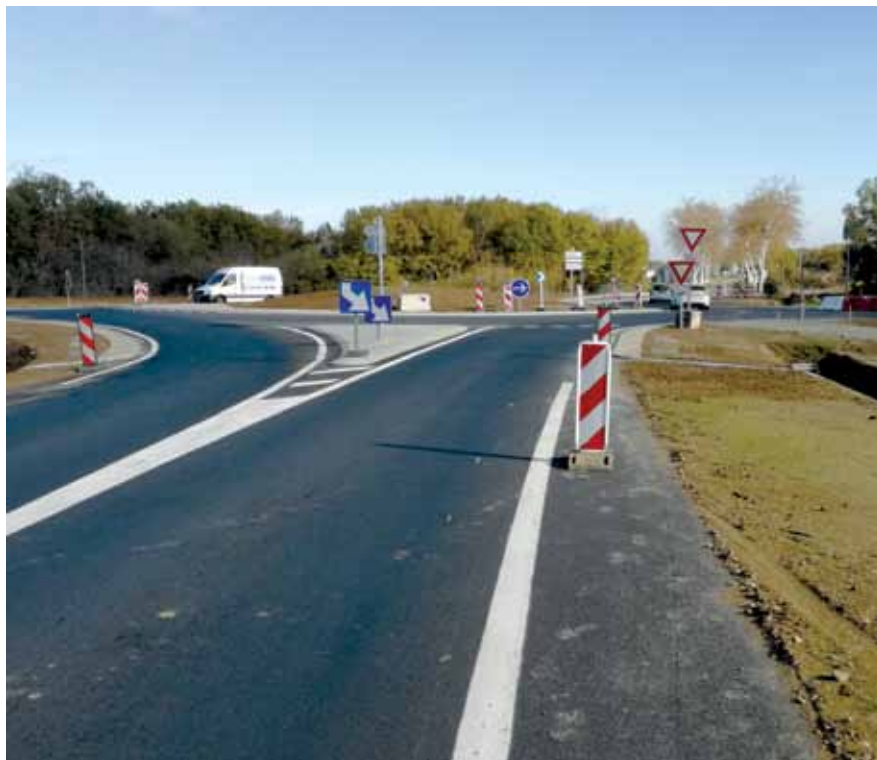
Giratoire route de Toulouse (RD 632)
