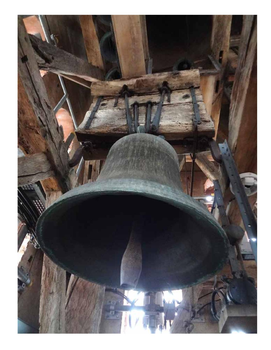
Chacune d'elles dispose d'un marteau actionné par un mécanisme dont le clavier est situé dans un compartiment proche.
