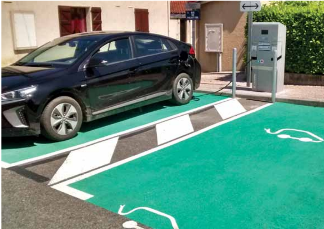
Borne de recharge électrique parking du Maquis
