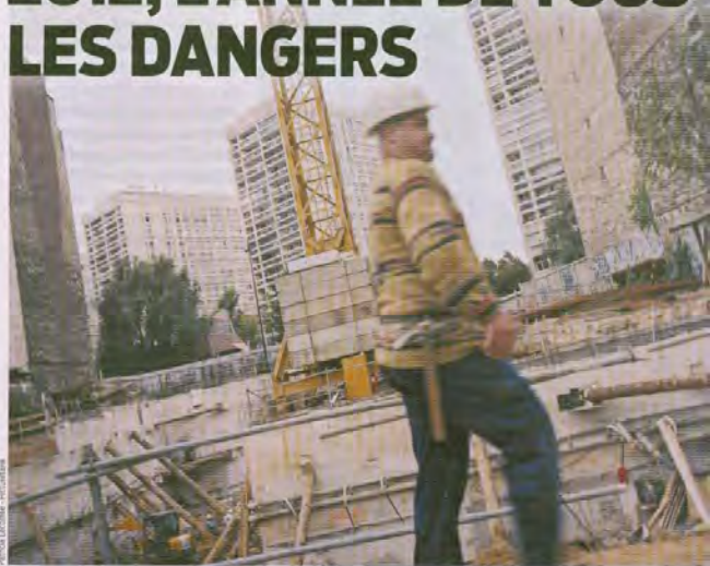
Travaux publics à Paris. Les problèmes financiers des collectivités locales pourraient sérieusement entraver les investissements publics.
